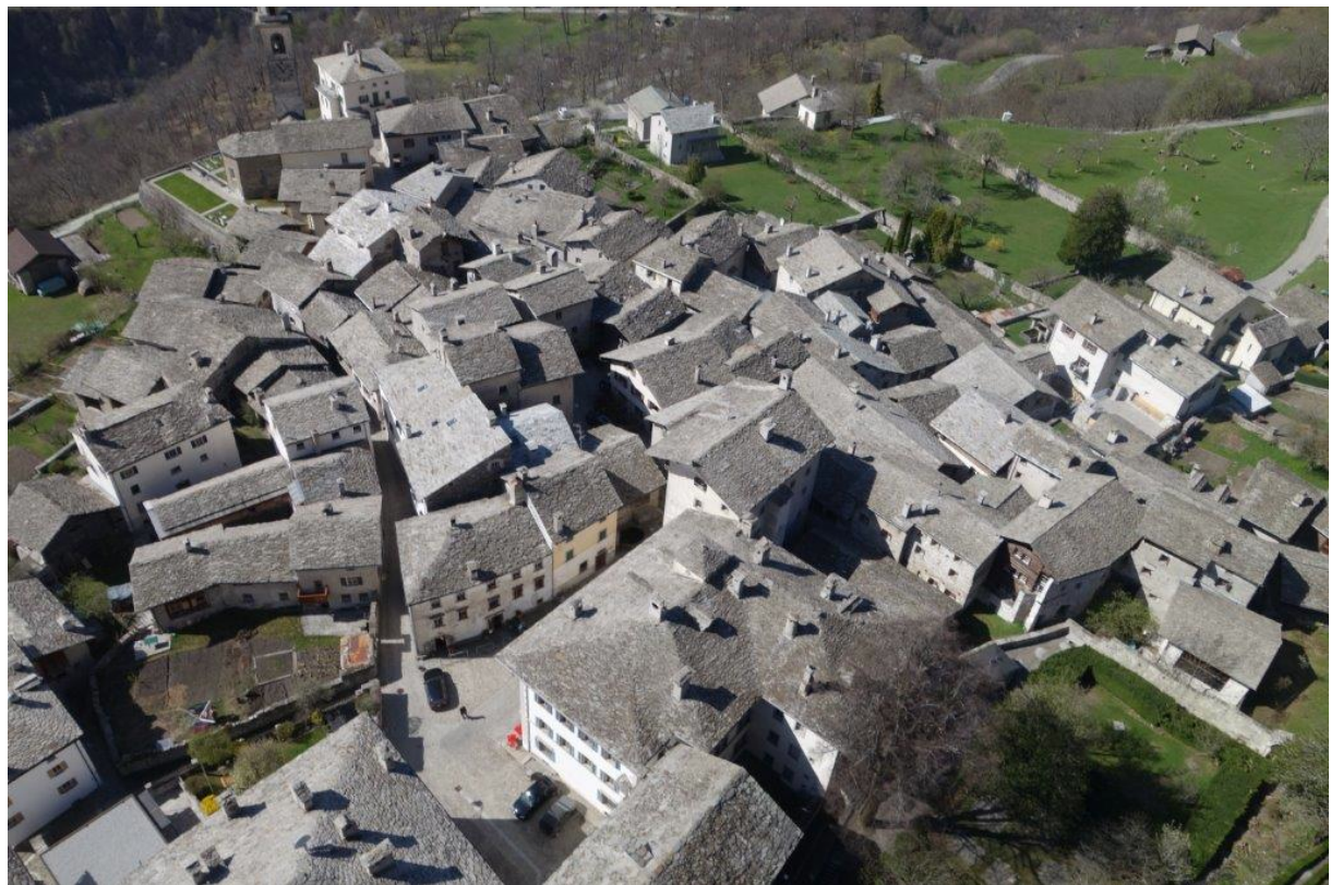
Drohenaufnahme der Dachlandschaft von Soglio, 2015
